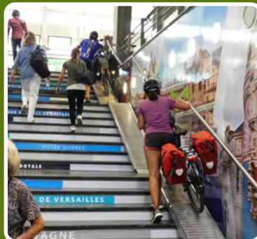
La rampe idéale aussi pour les autres usagers. Une goulotte assez large évite de coincer guidon et sacoches dans la main courante.
